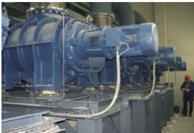
▲ Impianto per vuoto a 4 stadi con portata 2 x 30.000 m 3 /h nel degassaggio dell'acciaio ▼
