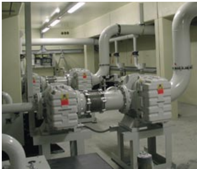
▼ Gruppo pompa a tre stadi per 2 x 12.000 m 3 /h nella tecnica delle incisioni
